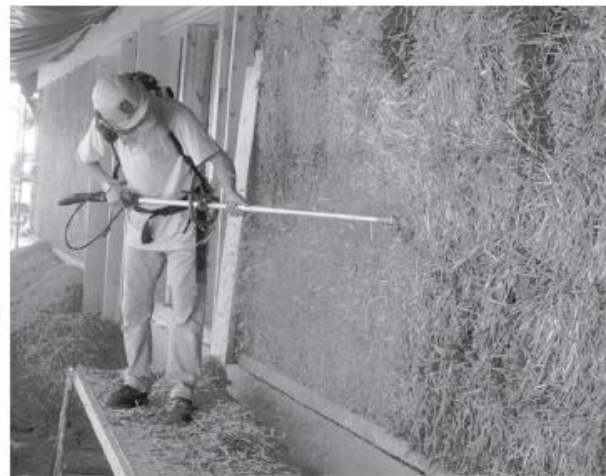
Fig. 3.12. Dressage de parois en paille avant réalisation des enduits
