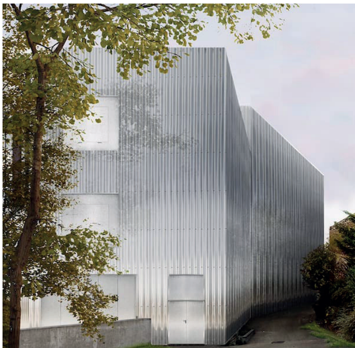
Vue de la façade est des réserves (à gauche) Photo de la façade des réserves en cours de chantier (à droite)
